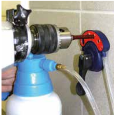
Exaktes Ansetzen des Bohrers, scharfe Bohrkante durch präzise Führung während des Bohrens
