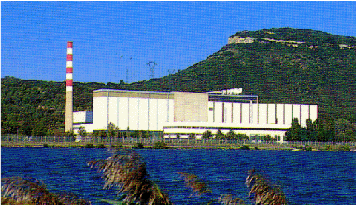
Phénix power plant.
