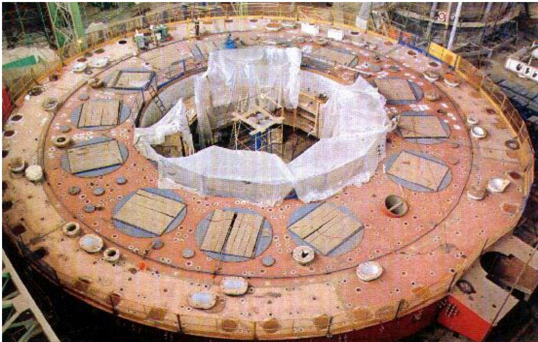
Super-Phénix 1 complete roof slab.
