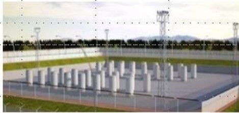
Completed ISF, Sta. Mª Garoña NPP
